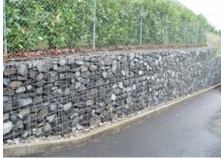
Muret en gabion
