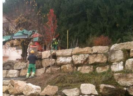
Enrochement de type cyclopéen
